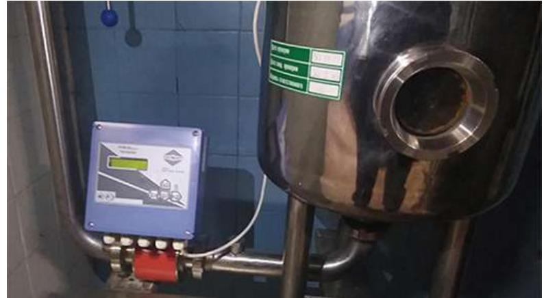
У пищевых расходомеров ТЭСМАРТ-РП есть возможность подключения датчиков давления и температуры для более полного контроля над измеряемой жидкостью. Используются термометры с нормированной статистической характеристикой Pt 100. Датчики избыточного давление на 1.6 МПа, с токовым выходом 4-20 мА.
